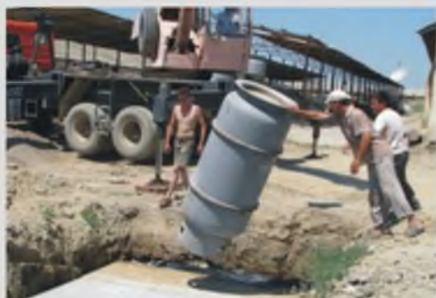
Установка газгольдеров
