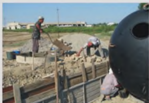
Подготовка опалубки для бетонирования стенок котлована
