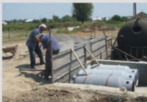
Подготовка опалубки для бетонирования стенок котлована
