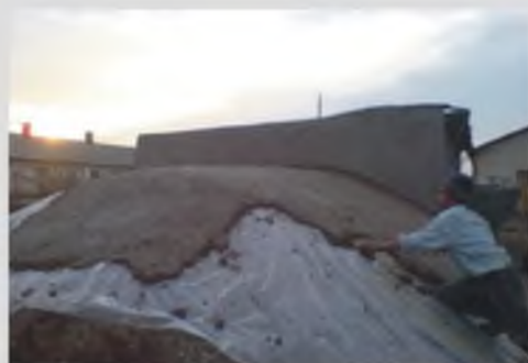
Для лучшей теплоизоляции весь реактор покрыт стекловатой и засыпан гравием
