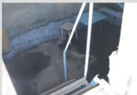
Лестница для спуска в рабочее помещение
