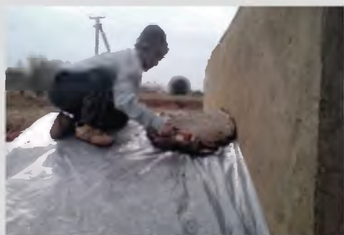
Последние изоляционные слои пленка и глина
