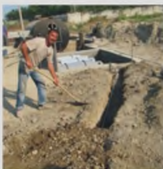
Прокладка газовых труб от газгольдеров до ГРП
