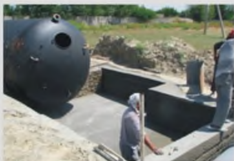
Работы по бетонированию стенок и дна котлована и возведению стены между рабочим отсеком и газгольдерами
