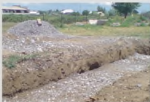
На дно котлована установлены бетонные блоки и засыпаны гравием
