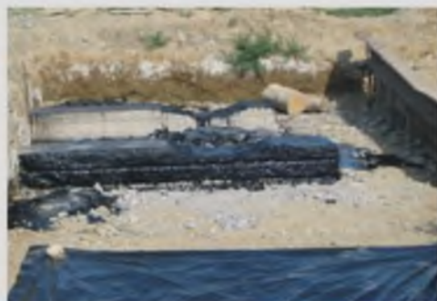
Для установки реактора подготовлен фундамент
