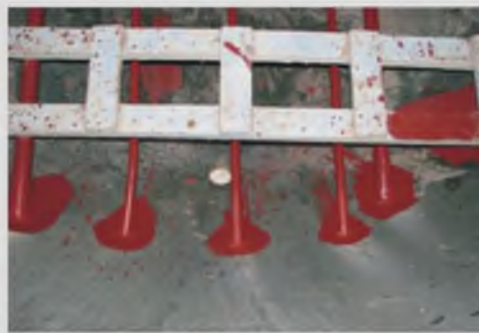
Отопительный контур и система перемешивания внутри цистерны, трубы и стыки покрыты суриком во избежание коррозии
