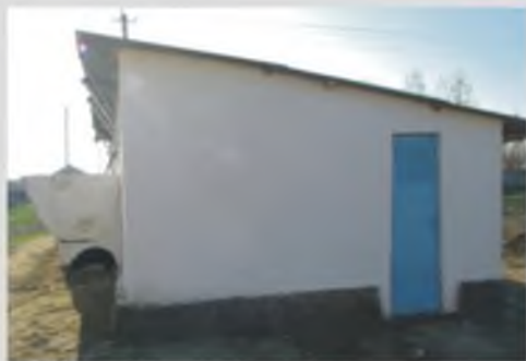
Внешний вид помещения биогазовой установки
