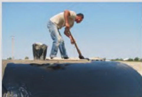
Покрытие внешней части цистерны смолой для гидроизоляции
