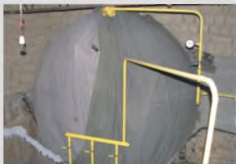
Передняя стенка биореактора
