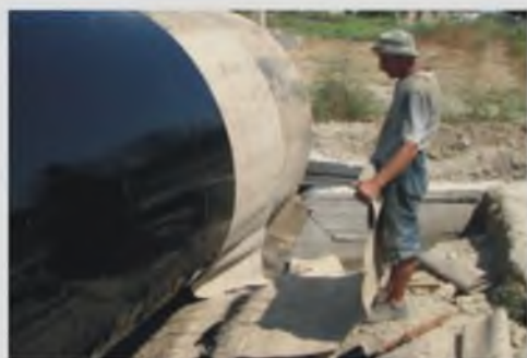
Цистерна покрыта смолой и рубероидом для гидро- и термоизоляции
