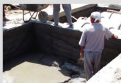
Работы по бетонированию стенок и дна котлована и возведению стены между рабочим отсеком и газгольдерами
