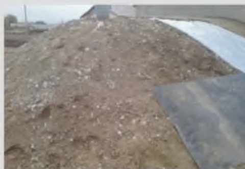
Для лучшей теплоизоляции весь реактор покрыт стекловатой и засыпан гравием
