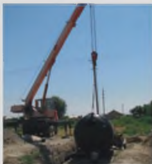
Установка реактора в котловане
