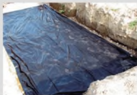
Дно котлована покрыто пленкой для гидроизоляции
