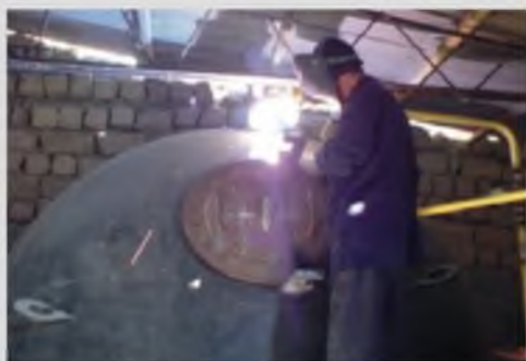
Монтаж герметичного люка
