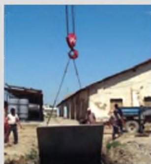
В отсек для установки газгольдеров помещена плита
