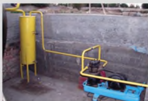
Предохранительный клапан и компрессор для перекачки биогаза ИФ-56
