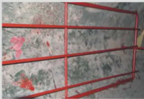
Отопительный контур и система перемешивания внутри цистерны, трубы и стыки покрыты суриком во избежание коррозии
