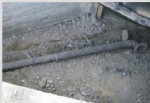
Подготовка к монтажу отводящей трубы
